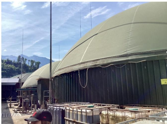
*In dieser Anlage wird die Gülle durch Bakterien zersetzt. Die Ballon-Kuppeln nennt man Fermenter.*
